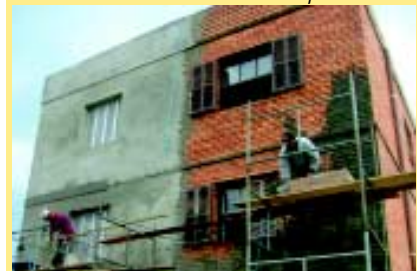
Prédio está em reforma desde julho
