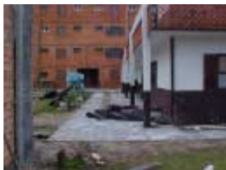
Passeios com pedras de ardósia
